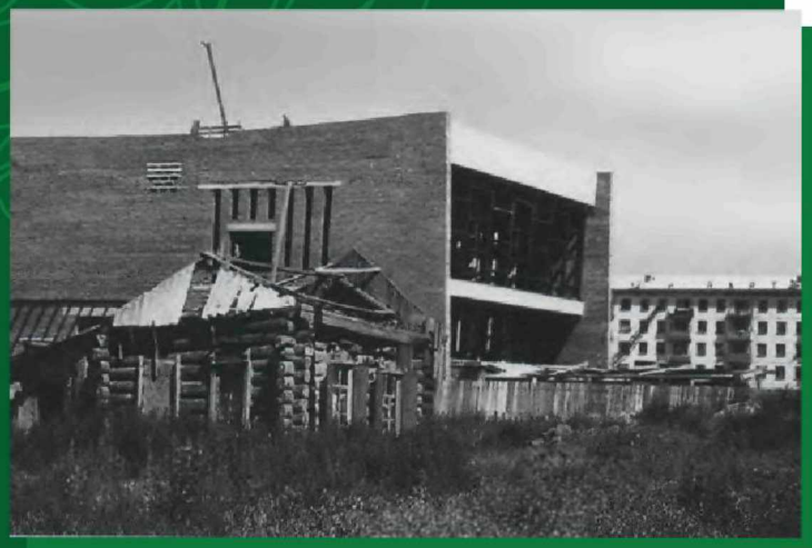
Начало строительства кинотеатра.
