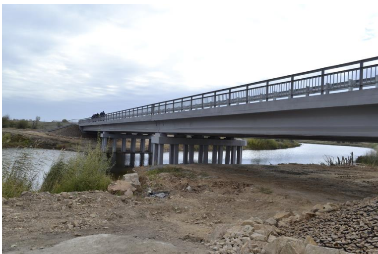
Новый мост через Склоиху
